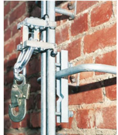
Befestigung der Fallschutzschienen mittig auf den Steigeisen
