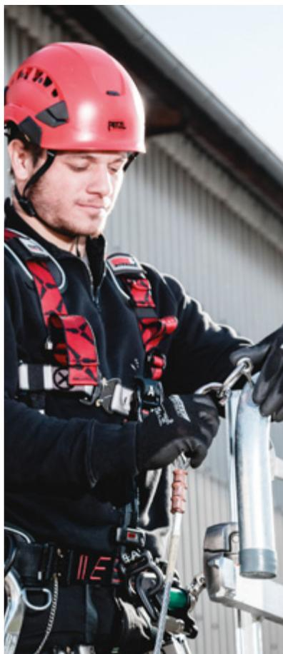
Erst wird das Zugangssicherungsseil mit der Brustöse des Gurtes verbunden
