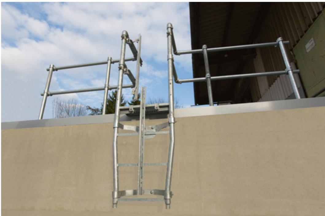
Ausstiegsgeländer (2 Sets) mit einschwenkbarer Einstiegshilfe
